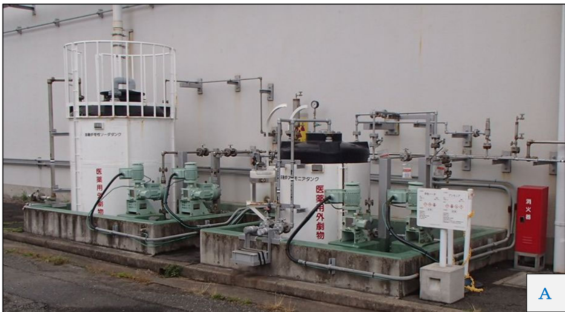
第2図 堰周りの状況（熔融炉アンモニアタンク）
