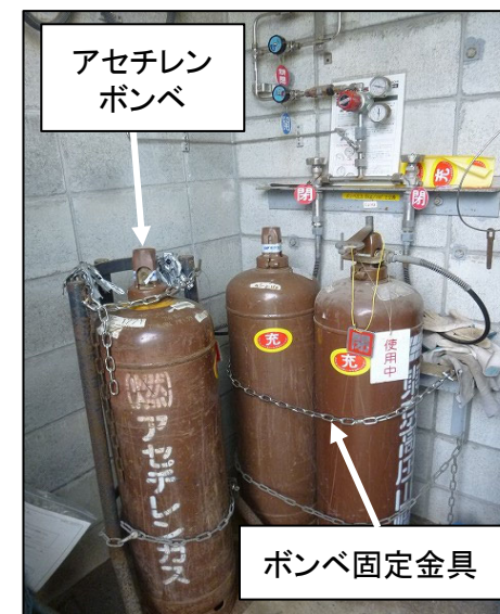
図18 敷地内におけるボンベの設置状況
