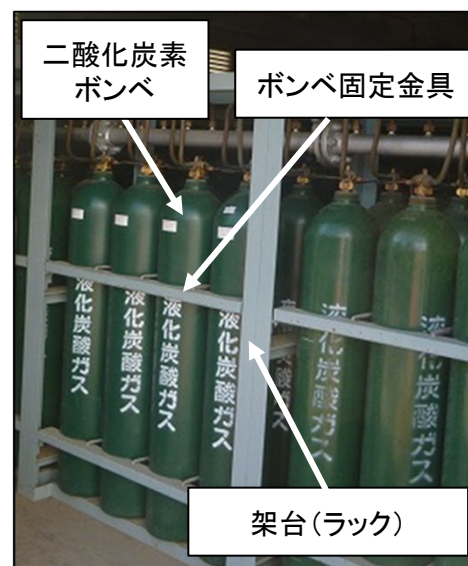
図18 敷地内におけるボンベの設置状況
