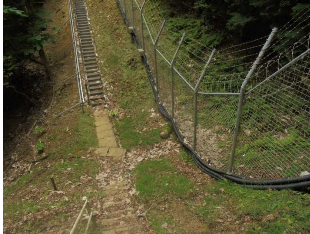
図2 仮設門扉設置予定地
