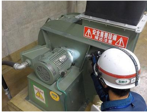
空調機起動状態確認
