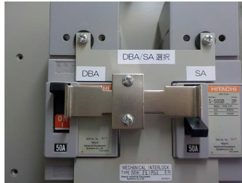
第2図 機械式インターロックの例
