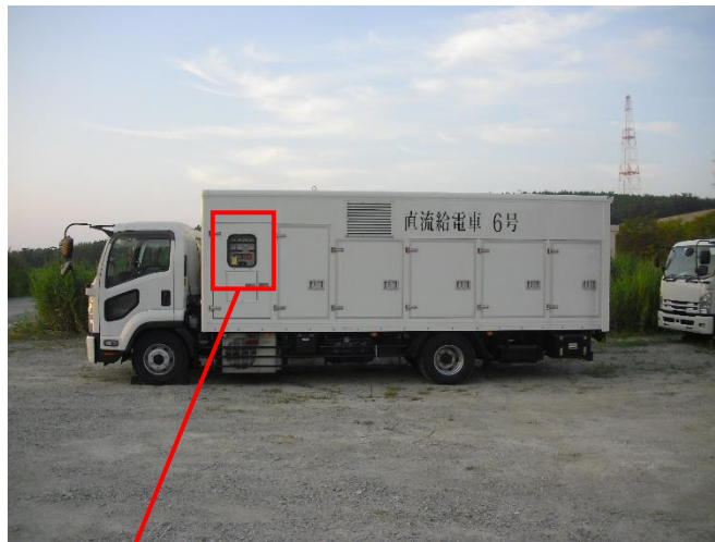
直流給電車操作部
