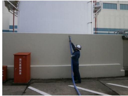
軽油タンクへのホース接続
