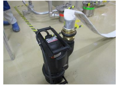
水中ポンプ設置状況
