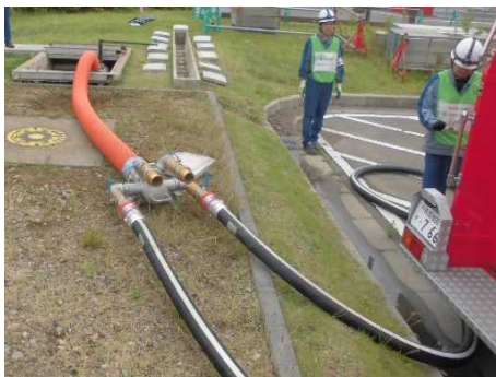
[防火水槽を水源とした場合] 防火水槽への吸管投入
