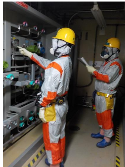
減圧状況の確認（現場）
