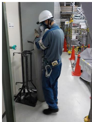
予備ポンベ交換
