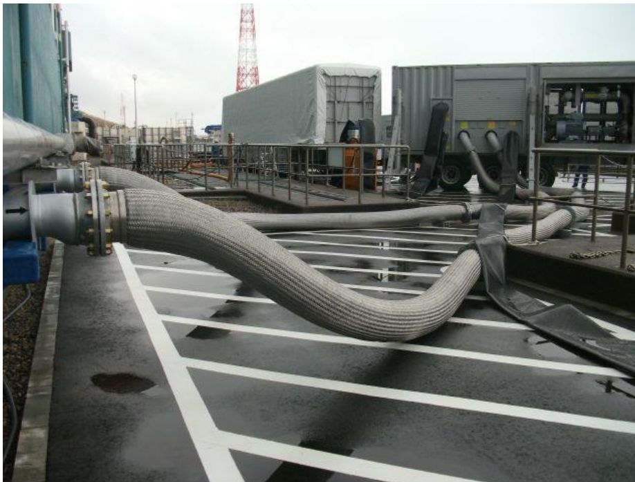
熱交換器ユニット設置
