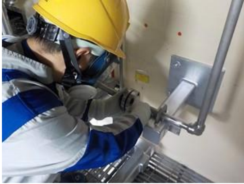
仮設ホース接続
