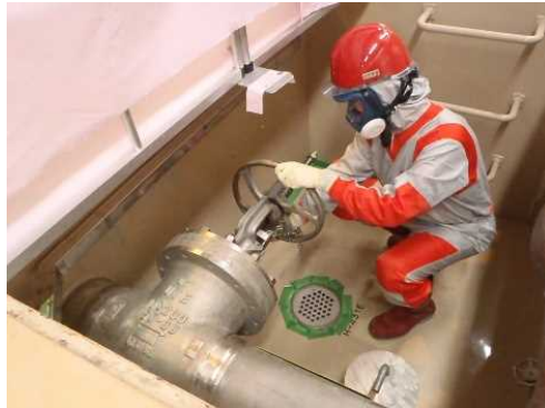
現場での隔離操作
