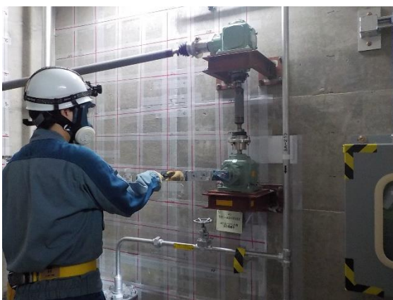
系統構成（遠隔手動弁操作設備）
