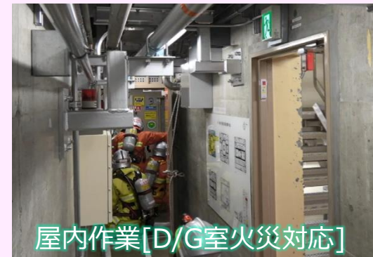
屋内作業[D/G室火災対応] 煙の状況を確認するなど、安全を確保 をした上での消火活動
