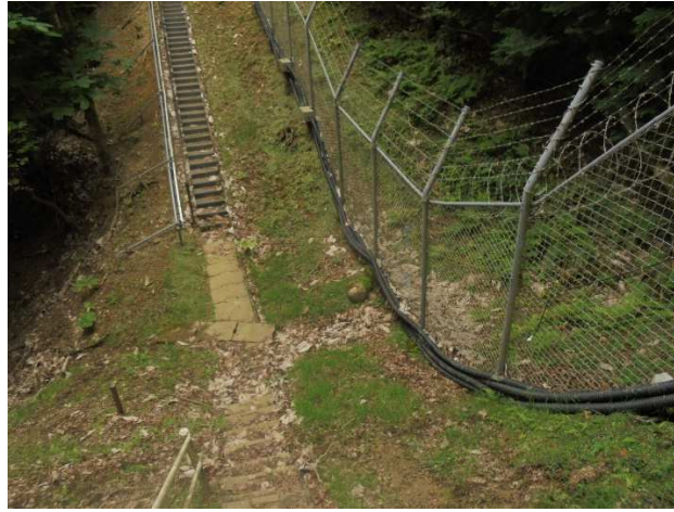
図2 仮設門扉設置予定地
