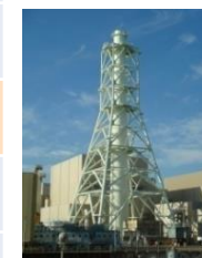
排気筒改造工事
