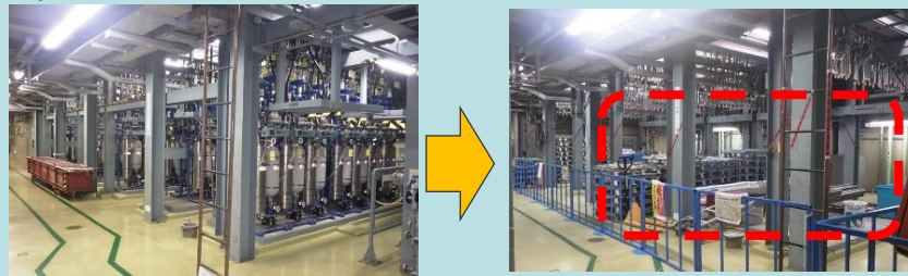
○浜岡 2 号制御棒駆動水圧制御ユニット解体 (原子炉建屋内)
