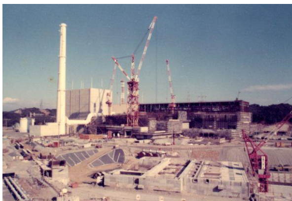
2号機建設工事中
