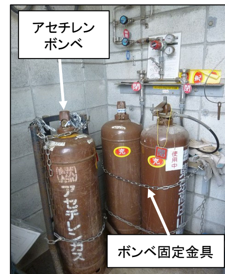
図18 敷地内におけるボンベの設置状況
