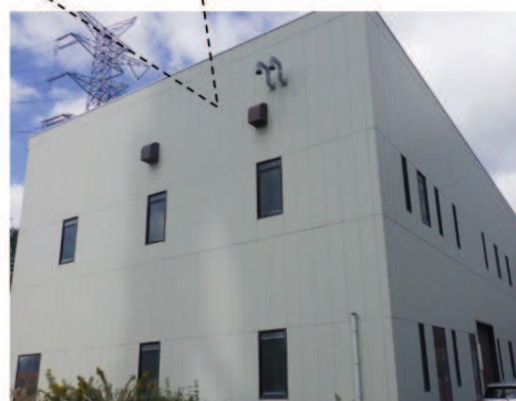
図1 建屋内風速の測定状況（3号機給排水処理建屋）
