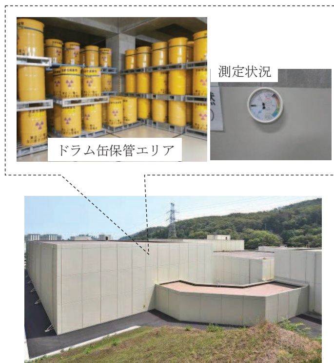
図2 建屋内温度の測定状況（固体廃棄物貯蔵所）
