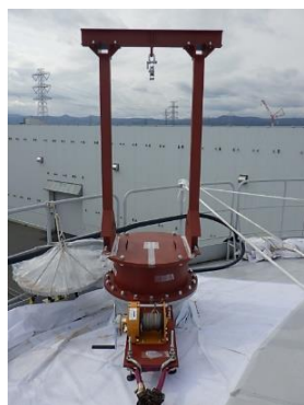
攪拌機器の 設置状況
