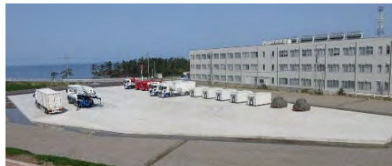
可搬型設備保管場所(南側)
