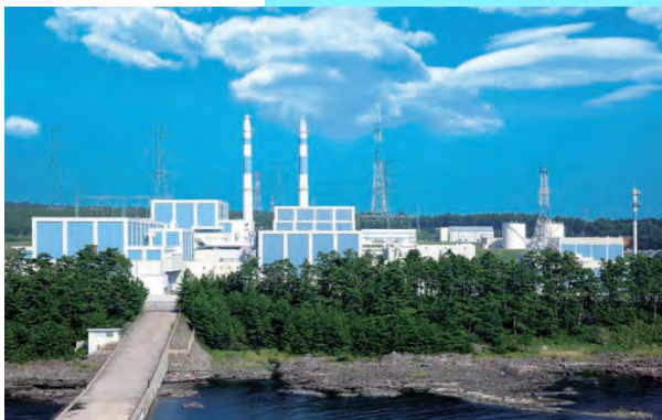
志賀原子力発電所
