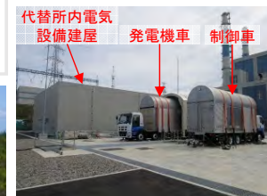
常設代替交流電源設備の設置
