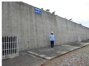
防潮堤の設置
