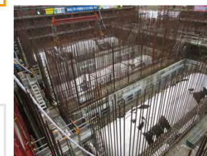
地下式軽油タンクの設置 (2017年1月)
