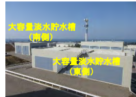
大容量淡水貯水槽の設置
