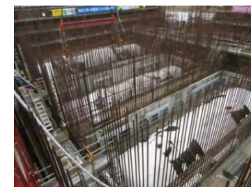
地下式軽油タンクピット内搬入 (2017年1月25日)
