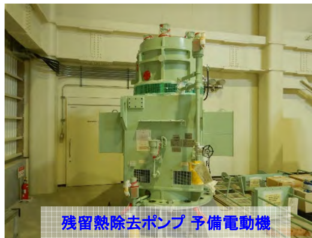
倉庫内資機材保管状況
