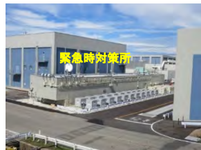
緊急時対策所(外観)
