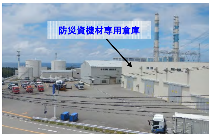
防災資機材専用倉庫 外観
