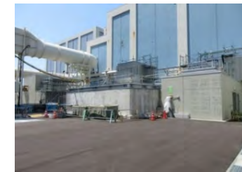
格納容器フィルタ付ベント装置建屋
