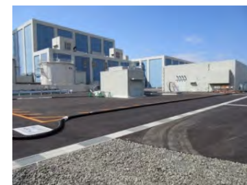
地下式軽油タンク 設置工事状況 (2019年4月17日)
