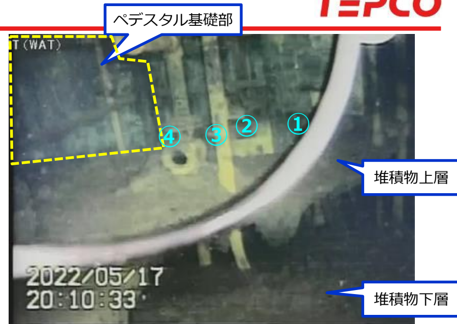
写真1.ペDESTアル基礎部(上部)の状況
