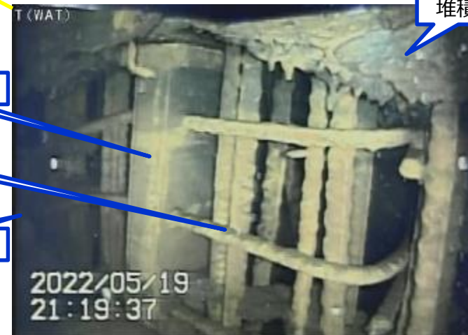
写真2.ペDESTAL開口部(右側基礎部)の状況
