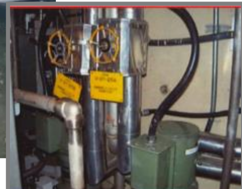
(参考写真)2011年事故前の状況
