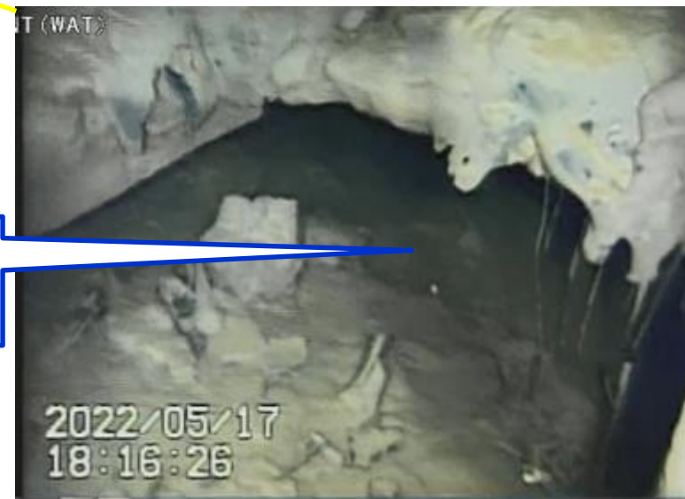
写真3.PCV底部の堆積物の状況(空洞内部)
