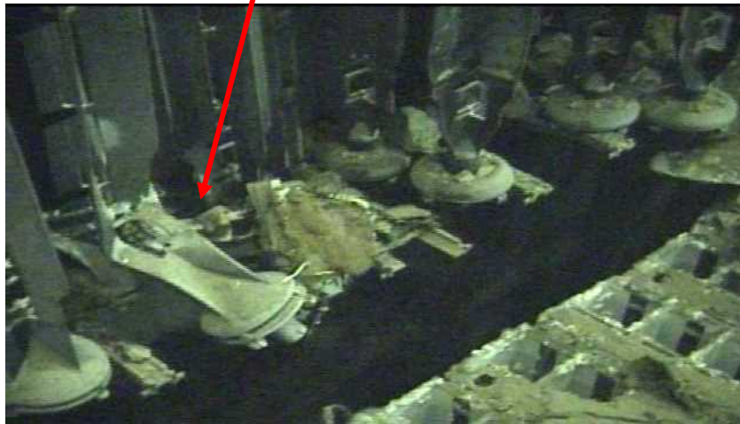
制御棒下部に変形
