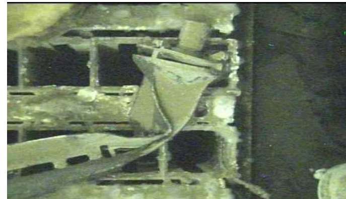
制御棒下部に変形
