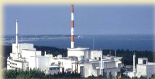
高速実験炉「常陽」
