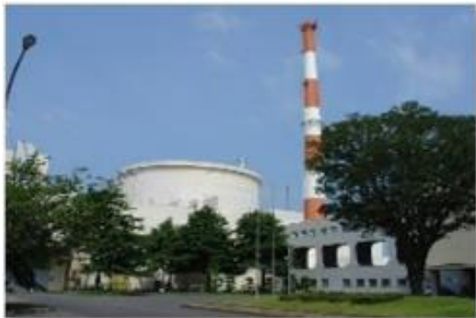
高速実験炉「常陽」
