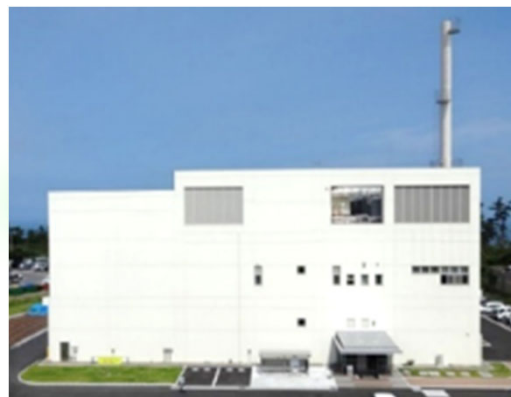
OWTF (平成31年3月施設完成)
