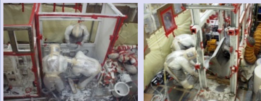
グリーンハウス内での解体撤去作業
