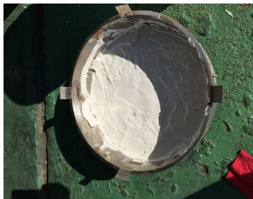
内面への接着剤塗布後
