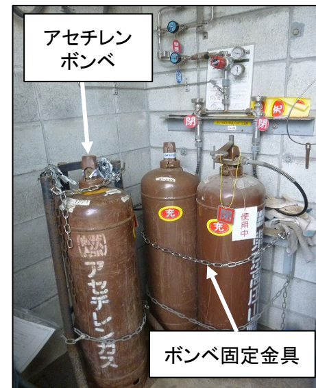
図18 敷地内におけるボンベの設置状況
