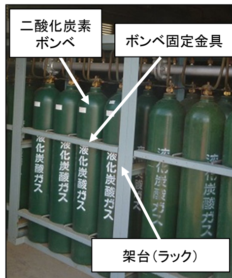
図18 敷地内におけるボンベの設置状況
