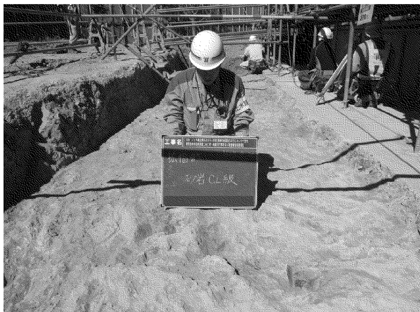
(砂岩 CL級の出現状況)
