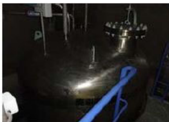
(①廃樹脂供給タンク 上部)
