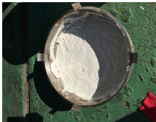
内面への接着剤塗布後
