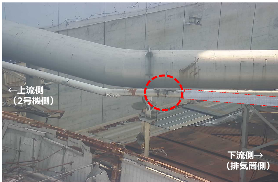
1号タービン建屋屋上から撮影
