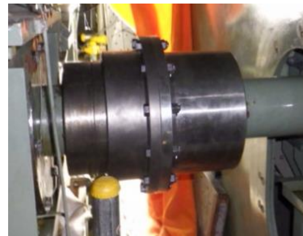
ギアカップリング交換後(塗装前)
