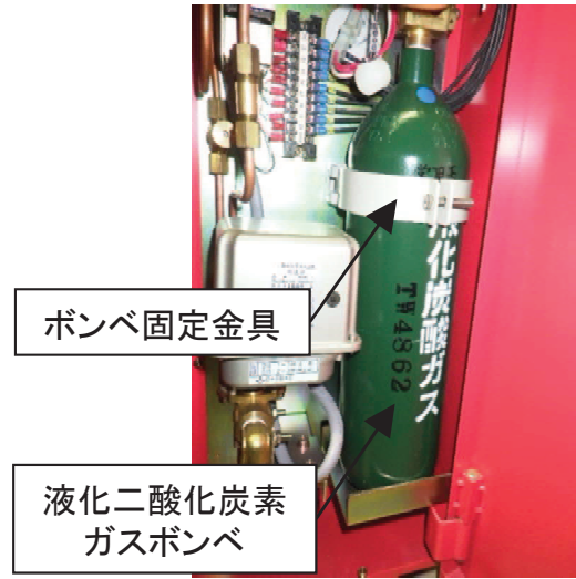
図17 発電所におけるボンベの設置状況
