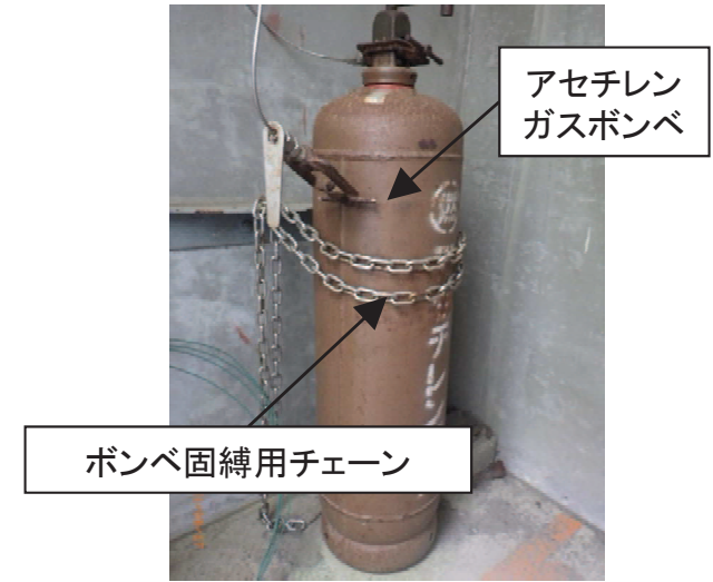
図17 発電所におけるボンベの設置状況
