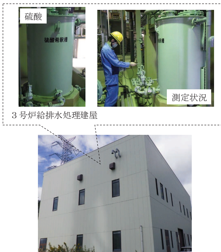
図1 建屋内風速の測定状況（3号炉給排水処理建屋）
