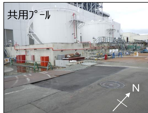
3月19日共用プール建屋大物搬入口前道路状況
