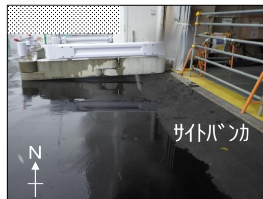
3月19日サイトバンカ建屋大物搬入口状況
