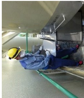
閉止板取付作業
