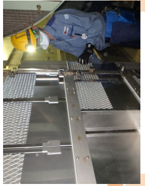
フィルタ抜取作業
