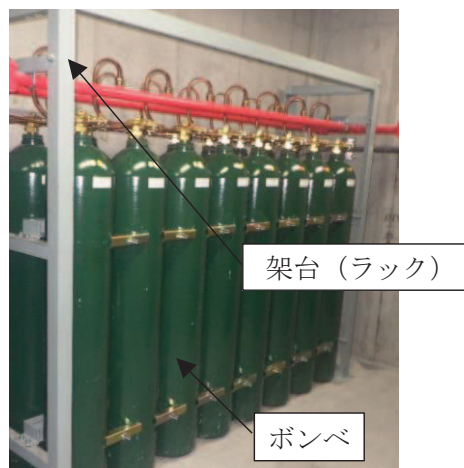
【3号炉原子炉建屋】 二酸化炭素ポンベ
