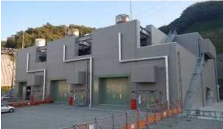
ガスタービン発電機建物 外観
