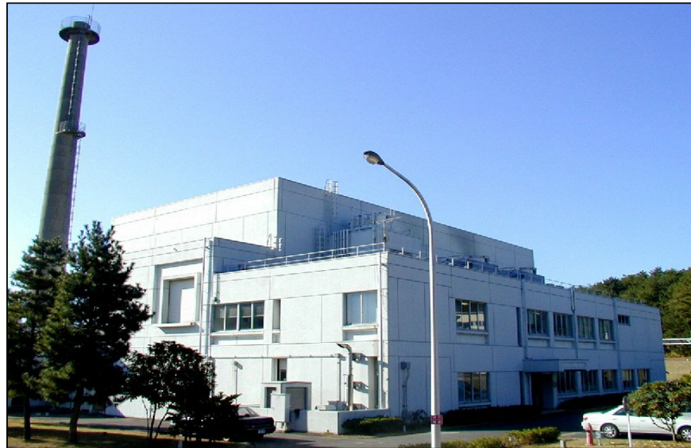
廃棄物安全試験施設(WASTE)の外観
