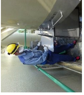
閉止板取付作業
