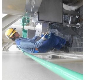
フィルタ抜取作業
