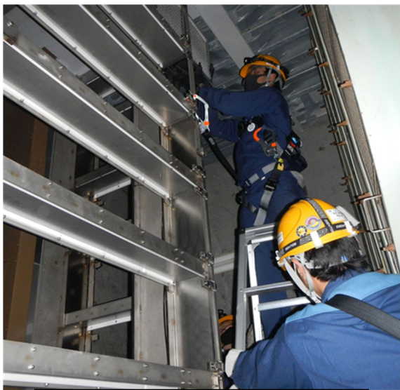
高所のフィルタ取付作業状況
