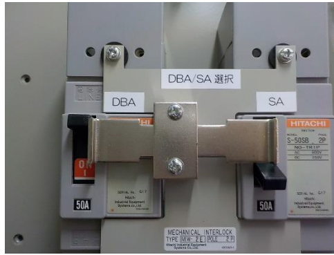
第2図 機械式インターロックの例
