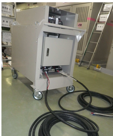
可搬式整流器への ケーブル接続 (安全補機開閉器室)
