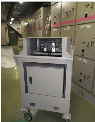
可搬式整流器の運搬 (安全補機開閉器室)
