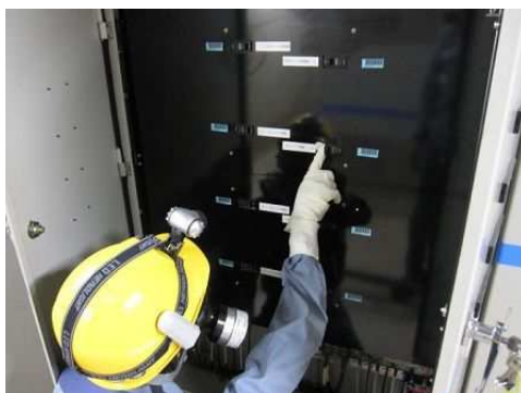
直流電源受電操作 （充電器室）
