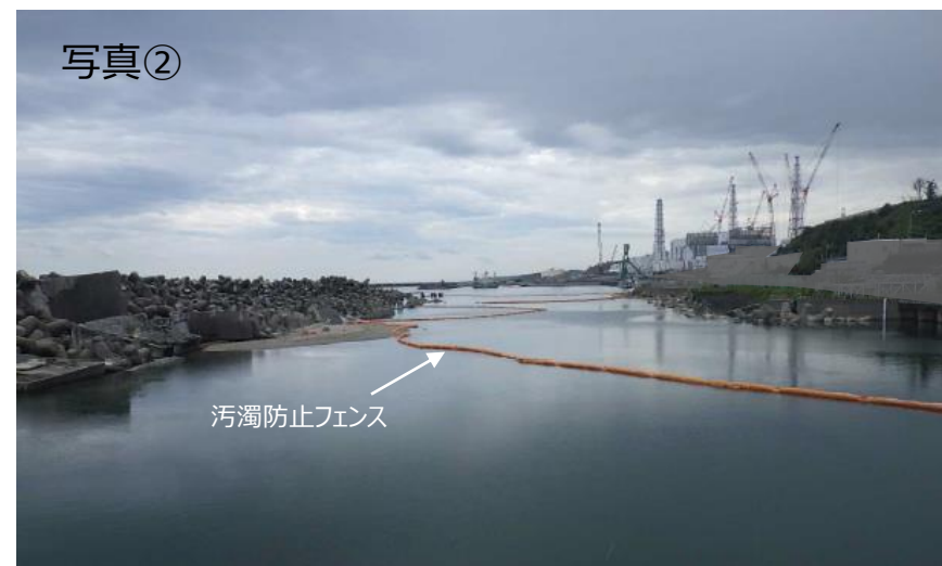
5/6号機取水路開渠内での工事における汚濁防止フェンス設置実績
