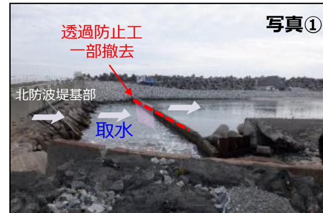
透過防止工撤去イメージ図
