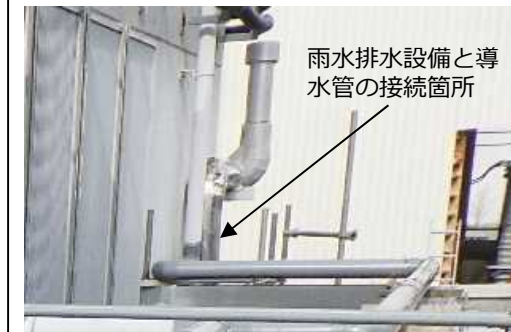
仮設導水管設置箇所
