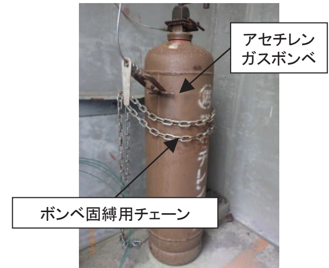
図17 発電所におけるボンベの設置状況
