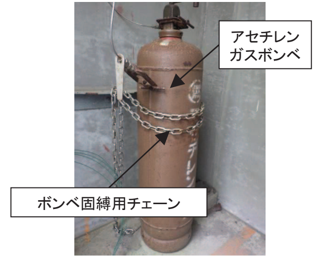
図17 発電所におけるボンベの設置状況
