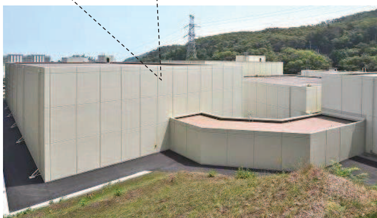
図2 建屋内温度の測定状況（固体廃棄物貯蔵所）
