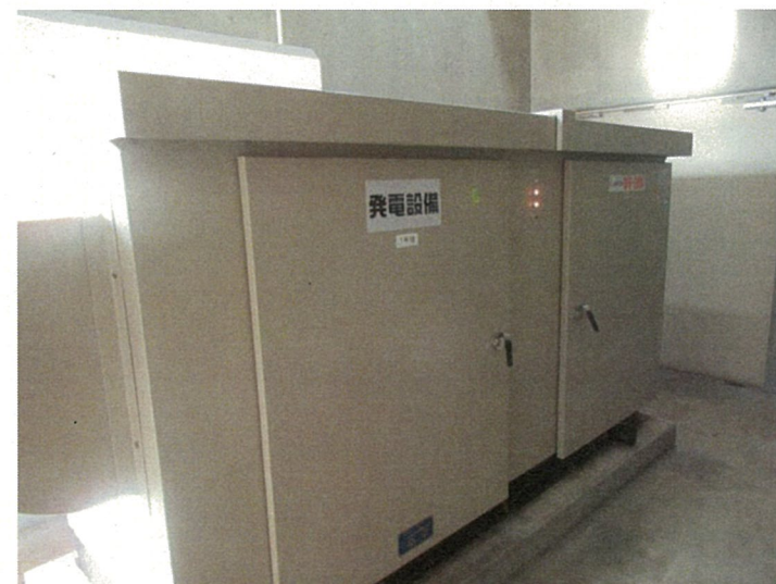
写真：EG 1号機の設置状況
