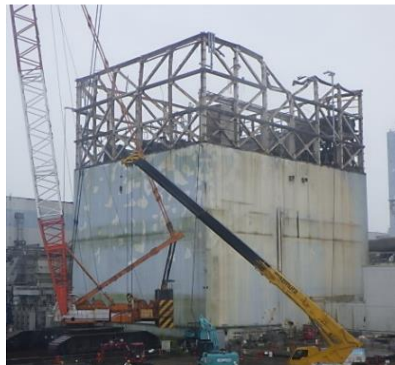
1号機原子炉建屋全景（2021年6月19日時点）
