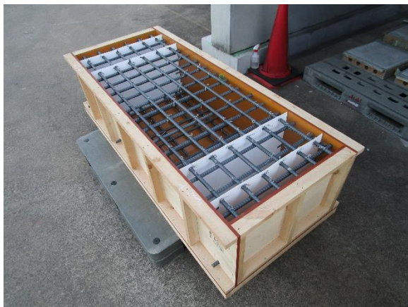
引抜試験体 打設前
