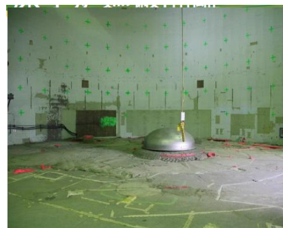
EBR-IIの原子炉遮へい隔離状況
