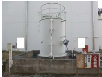
既設の灯油貯槽
