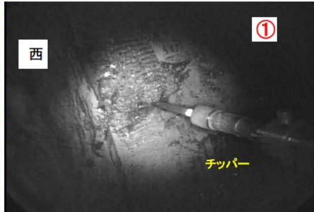
①西側傾斜面上部のはつり作業(R4.1.18)
