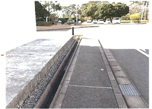
事務所周りの側溝
