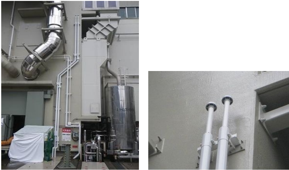
図2 燃料油貯油そうベント管の外観写真（右は拡大写真）
