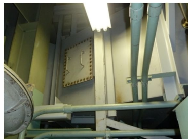
図 2 格納容器排気筒点検口（高浜 1 号炉の例）
