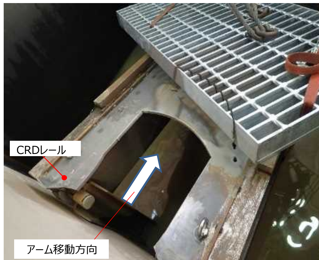
AWJ切断状況 (CRDレールとグレーチングを一部切断した状態)
