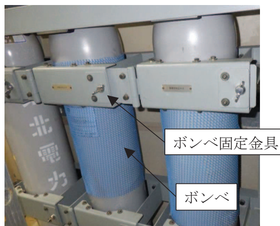
【2号炉原子炉建屋】 酸素ガスポンベ
