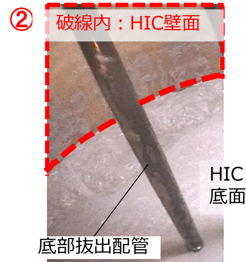
底部拔出配管吸込み口は残存スラリーの液面下であり、拔出終了後に周囲のスラリーが吸込み口近傍に流入したものと推定
