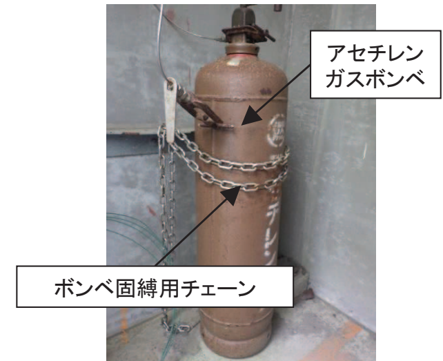
図17 発電所におけるボンベの設置状況
