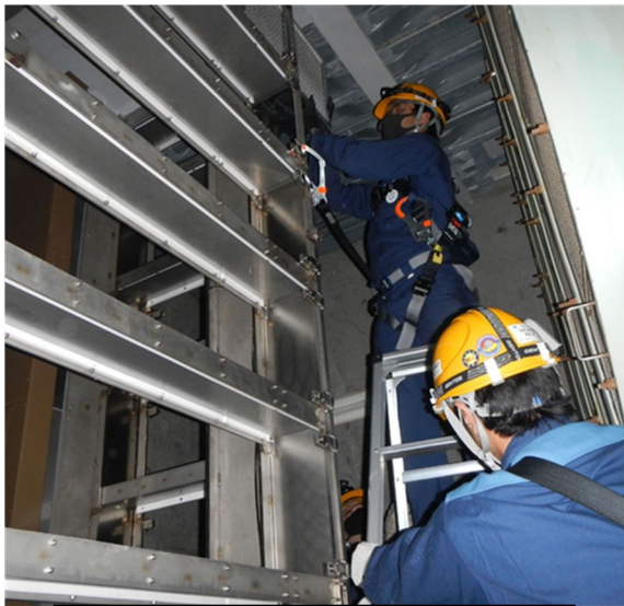
高所のフィルタ取付作業状況
